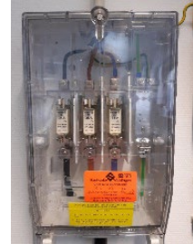
Beispiel Hausanschlusskasten
